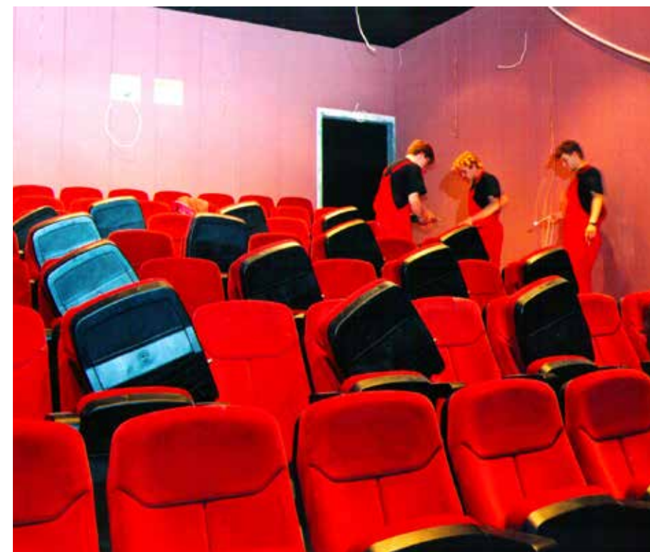
Kino Femina, 1996 Końcowy etap remontu – montaż foteli. Fot. własna, 1996
