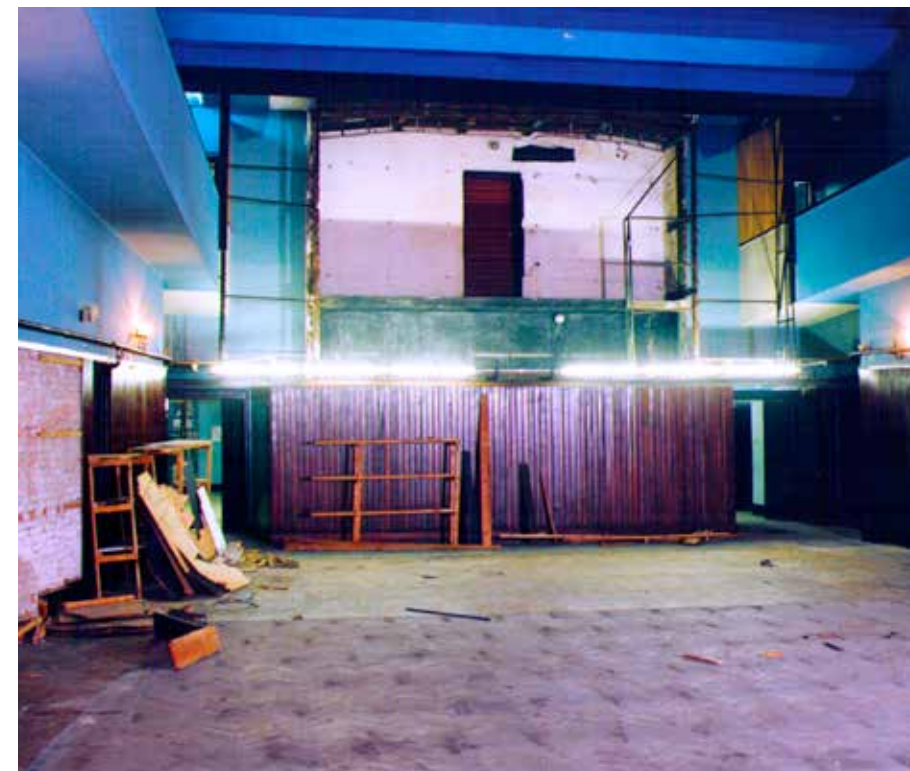
Kino Femina, 1994 Pierwszy etap remontu – demontaż wyposażenia sali: foteli i konstrukcji ekranu Fot. własna, 1994
